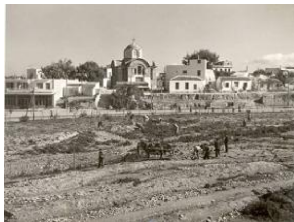
Οι εργασίες επιχωμάτωσης της τάφρου
