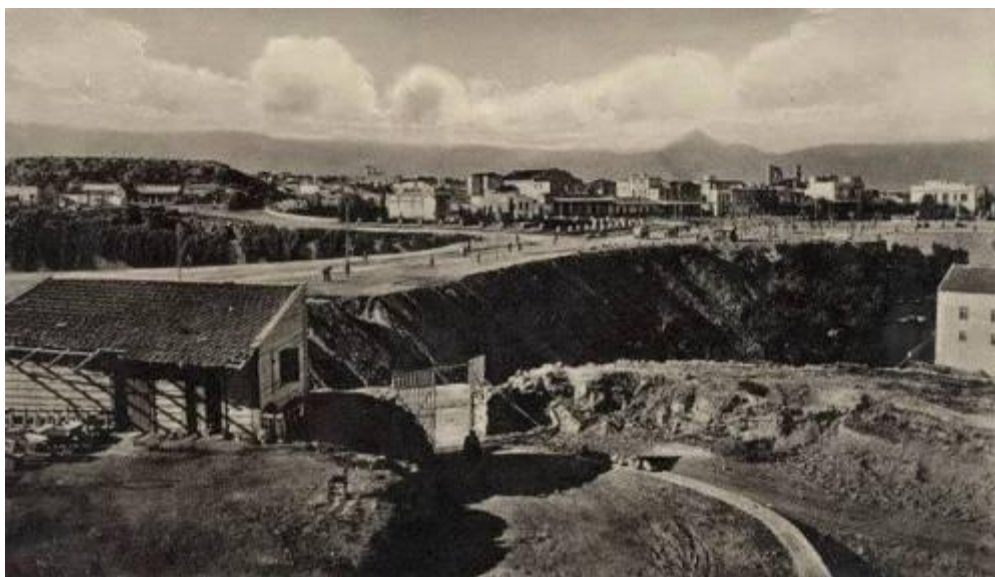
Η επιχωμάτωση της τάφρου για την διαμόρφωση της Λεωφ. Δημοκρατίας
