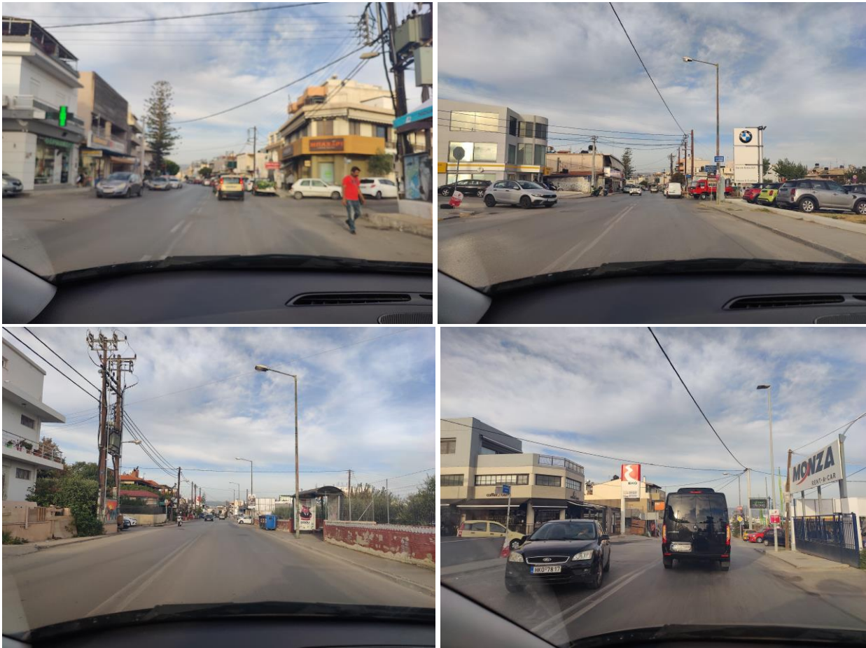
Εικόνα 38. Υφιστάμενη κατάσταση Α. Ικάρου τμήμα 3
